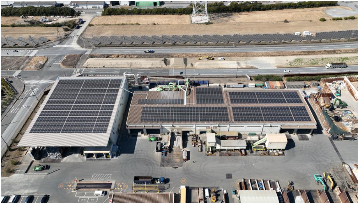
(太陽光パネルを設置した東港金属千葉工場全景)
